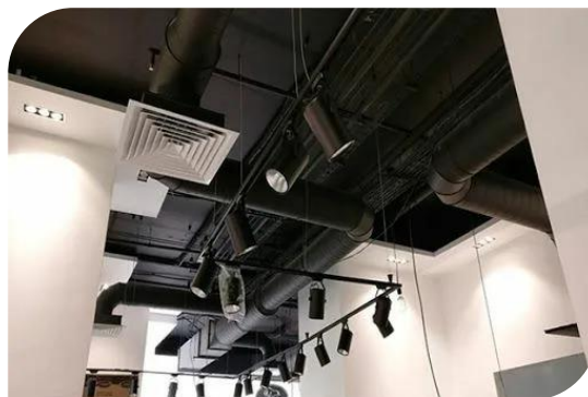
Окраска потолка и коммуникаций
